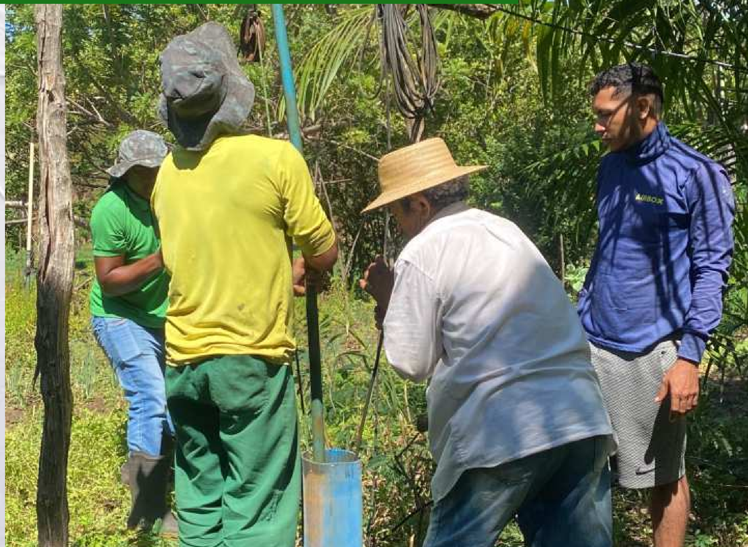
20 - Trabalho coletivo de manutenção no poço artesiano do Quintal do Josias e Luciana
